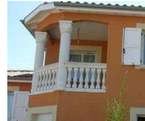
Type de balustres interdits
